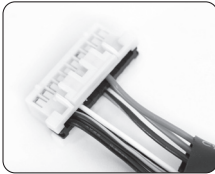
タイラップを切り伸縮チューブを ずらした状態
